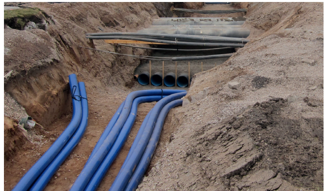
Zusätzliche PE-Leitungen DN 50 für die Kommunikation
