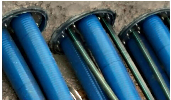
ddichter Verschluss der Leerrohrtrasse mit HRD-Dichtungen
