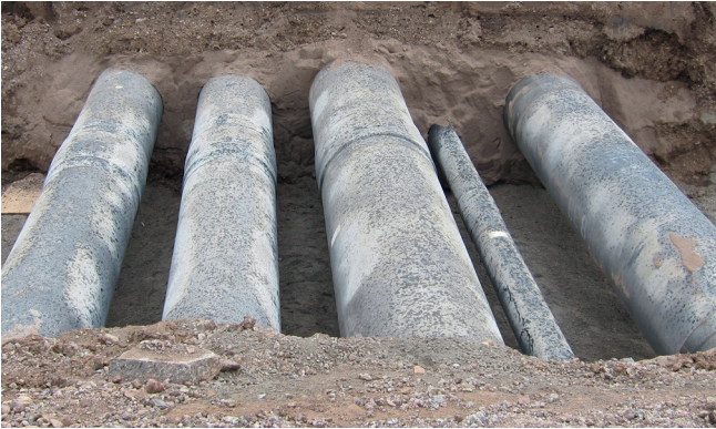
Ansicht der Fernwärmetrasse
