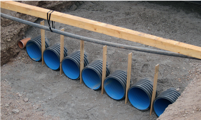
Verlegung der Leerrohre in Magerbeton
