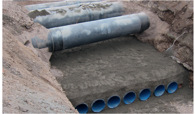
Unterführung der Fernwärmetrasse mit den Rohren
