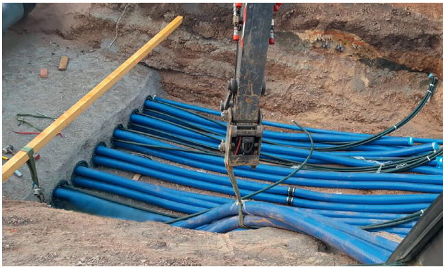
Rohr- und Kabelzug mit Hebetechnik
