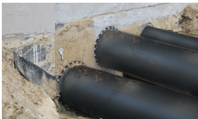
Die gas- und wasserdichte Abdichtung des Gebäudes im Einführungsbereich der Rohre erfolgt mit Gliederketten (GKD) in unterschiedlichen Dimensionen.
