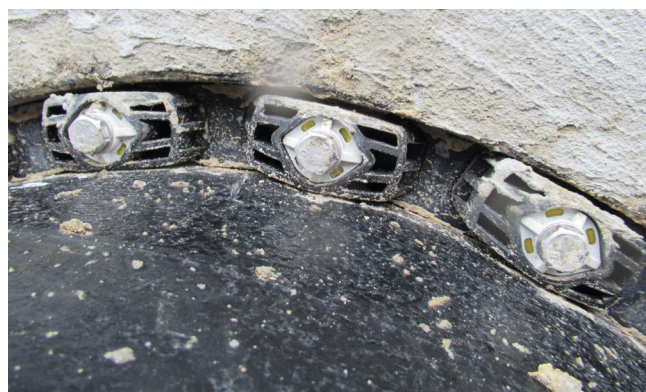
Die gelbe Montagekontrolle der Gliederkette zeigt dem Anwender, dass die Kette fachgerecht montiert wurde.
