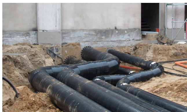
Die einzelnen Rohre werden in einer separaten Bohrung ins Gebäude eingeführt.
