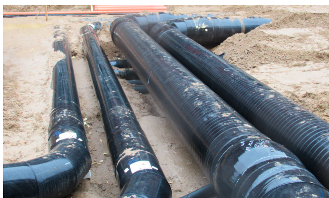
Verschiedene Kühl-/Stickstoff- und Sauerstoffleitungen in unterschiedlichen Dimensionen wurden zwischen den Gebäudeteilen verlegt und werden in die Gebäude eingeführt.
