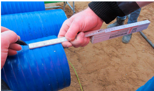
Einstecktiefe am Spiralschlauch markieren, dann die KES-M 150 Manschette aufschieben und mit vorgegebenem Anzugs-Drehmoment festziehen.
