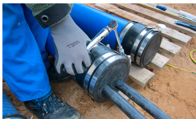
Mit vorgegebenem Drehmoment anziehen und fertig ist der universelle Endabschluss für geprüfte Leerrohrsysteme von Hauff-Technik.
