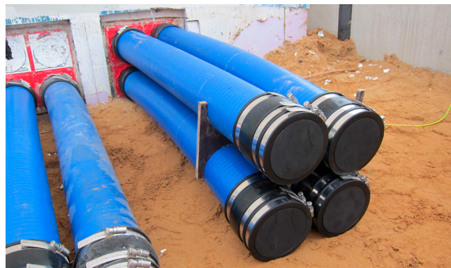
Bei vorübergehender Nichtbelegung, z.B. während der Bauphase, können die WE-SG-Einsätze als Blindabdichtung genutzt werden.
