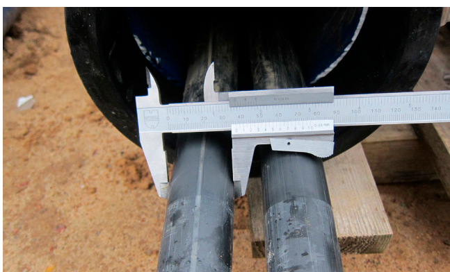
Bei Belegung der Spiralschläuche den WE-SG entfernen und die Kabel ins Gebäude führen. Den Außendurchmesser der Kabel mit Messschieber messen und den WE-SG entsprechend dem Außendurchmesser der Kabel anpassen.
