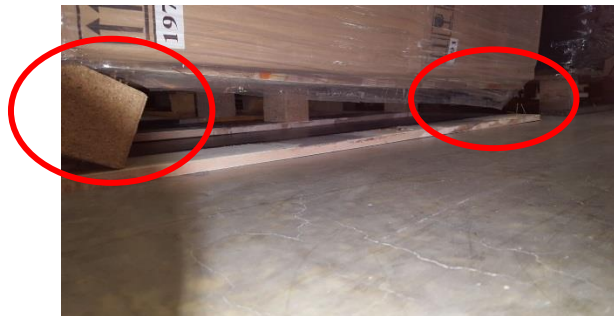
Abbildung 15: Palette – Beschädigung Klötze
