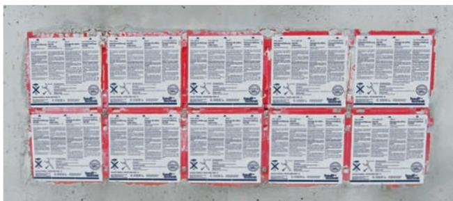
Doppeldichtpackung HSI 150 als Paket in Schalung eingesetzt
