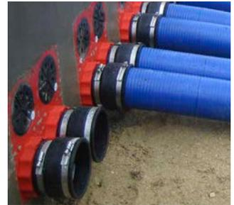
Druckdichter Anschluss an die HSI 150-Dichtpackungen
