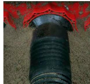
Wellrohranschluss mit Kaltschrumpftechnik HSI 150-D 110-KS
