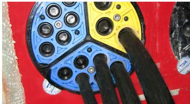
HSI 150 – SEGMENTO – mit integrierter Drehmomentkontrolle und Blindstopfen
