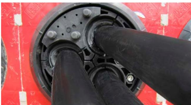
Pressplattenabdeckung HSI 150-PA-3/24-54
