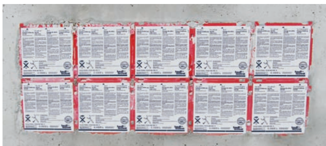
Doppeldichtpackung HSI 150 als Paket in Schalung eingesetzt
