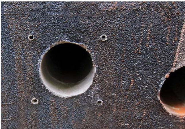
Kernbohrung und Dübellöcher
