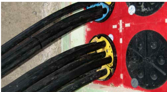
Abdichtung von Kabeln für Straßenbeleuchtung mit SEGMENTO
