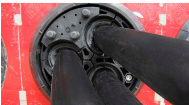
Pressplattenabdeckung HSI 150-PA-3/24-54
