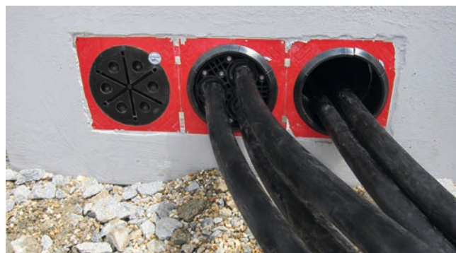
Verschiedene Montageschritte bei HSI 150-DG-3/24-54
