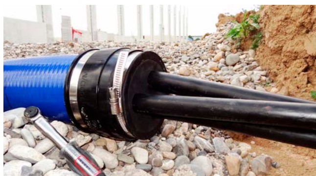
Abdichtung im Erdbreich am Ende des Spiralschlauches Hateflex 14150 mit dem Abdichtset KES-M 150 WE 160-SG-3/22-54
