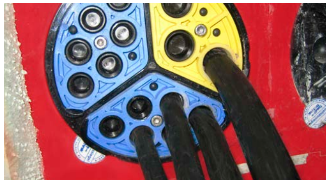
HSI 150 – SEGMENTO – mit integrierter Drehmomentkontrolle und Blindstopfen
