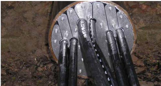
HRD200 G b30 in einem Stahlrohr
