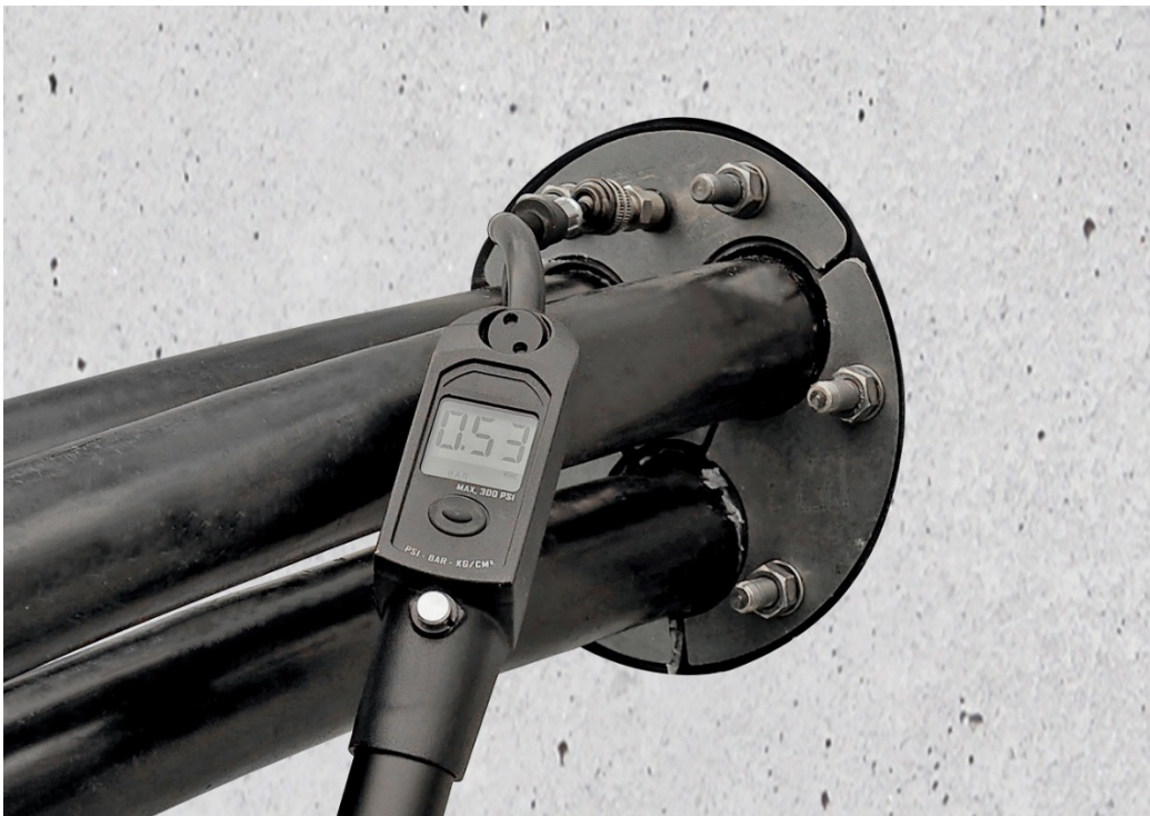
Bild 4: Praxiseinbau: Überprüfen der Dichtheit mittels Prüfpumpe
