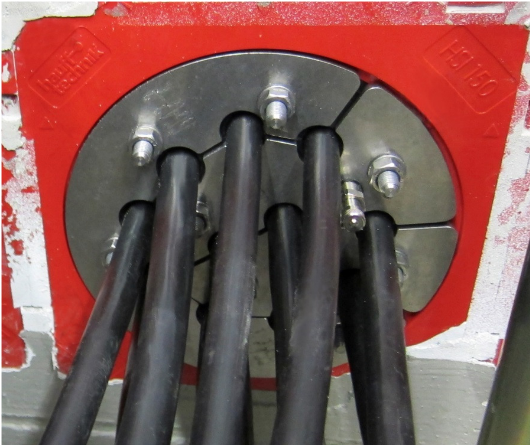
Bild 5: Eingebaute Ringraumdichtung HRD-PV in Dichtpackung HSI 150 – eingebaut in einer Trafostation
